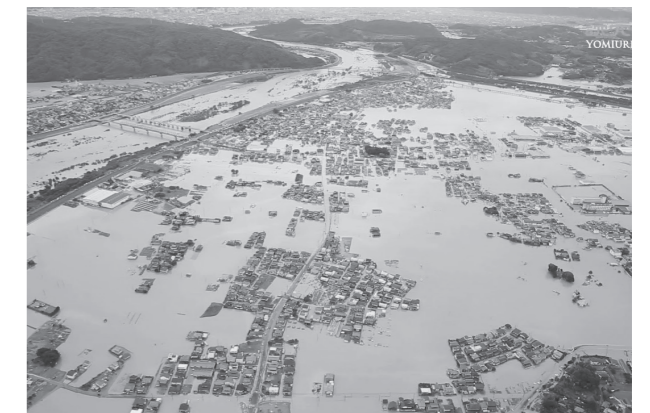
2018年7月 西日本豪雨災害 発生 (倉敷市)
